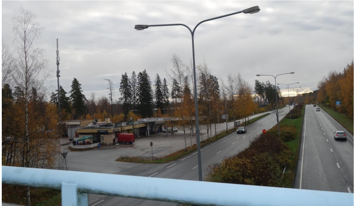
Kuva 8. Näkymä kantatieltä 65 kohti kaava-alueen eteläosassa sijaitsevaa entistä huoltoasemaa.
