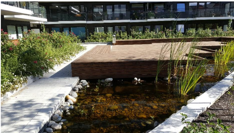
Kuva 12. Viivytyksallas, jossa on säilyvä vesipinta.
