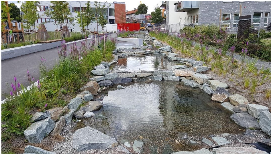
Kuva 15. Painanne, johon on tehty pohjapatoja viivytyksen aikaansaamiseksi.
