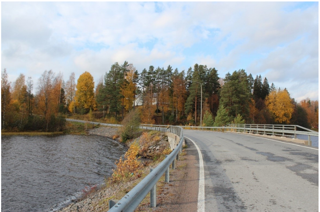
Kuva 2. Karhenjärven ylittävän sillan vastarannalla kallion päällä näkyy Karhen koulu. Vaikka puut osin peittävät Karhen koulua, on rakennus selvä maamerkki maisemassa.
