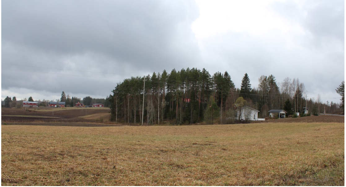
Kuva 1. Uudisrakennus on sijoitettu hyvin metsän reunaan ja maisemoitu pihapuilla. Perinteisen värinen julkisivu olisi sovittanut rakennuksen vielä paremmin kylämaisemaan.
