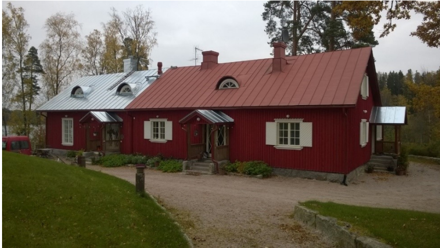
Kuva 3. Vanhan rakennuksen laajennus toteutettu rungon levyisenä, harjan suuntaisena (Petri Karvinen)
