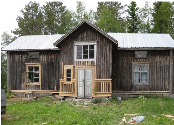
Kuva 2. Vain huonokuntoiset osat on korvattu uusilla puuosilla. (Saatsi Arkkitehdit.)
