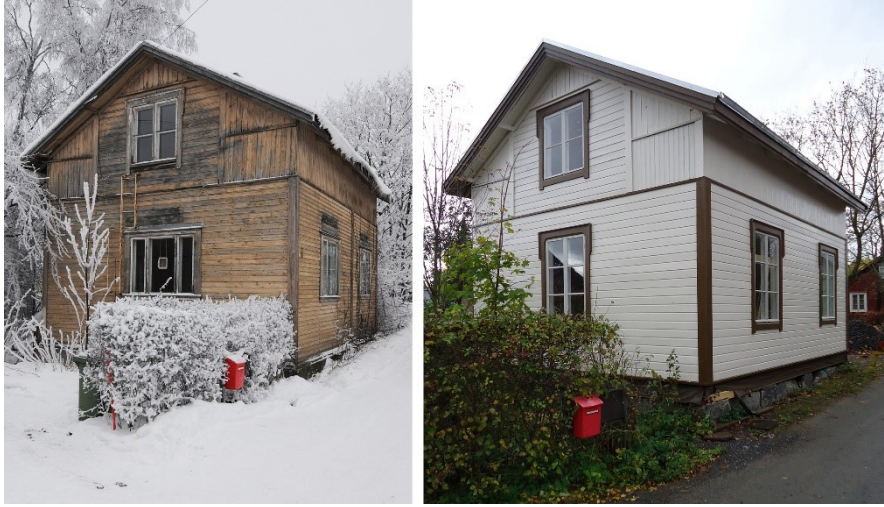
Kuva 1. Rakennuksen julkisivun korjaustyöt toteutettu vanhoja yksityiskohtia palauttaen (Saatsi Arkkitehdit)
