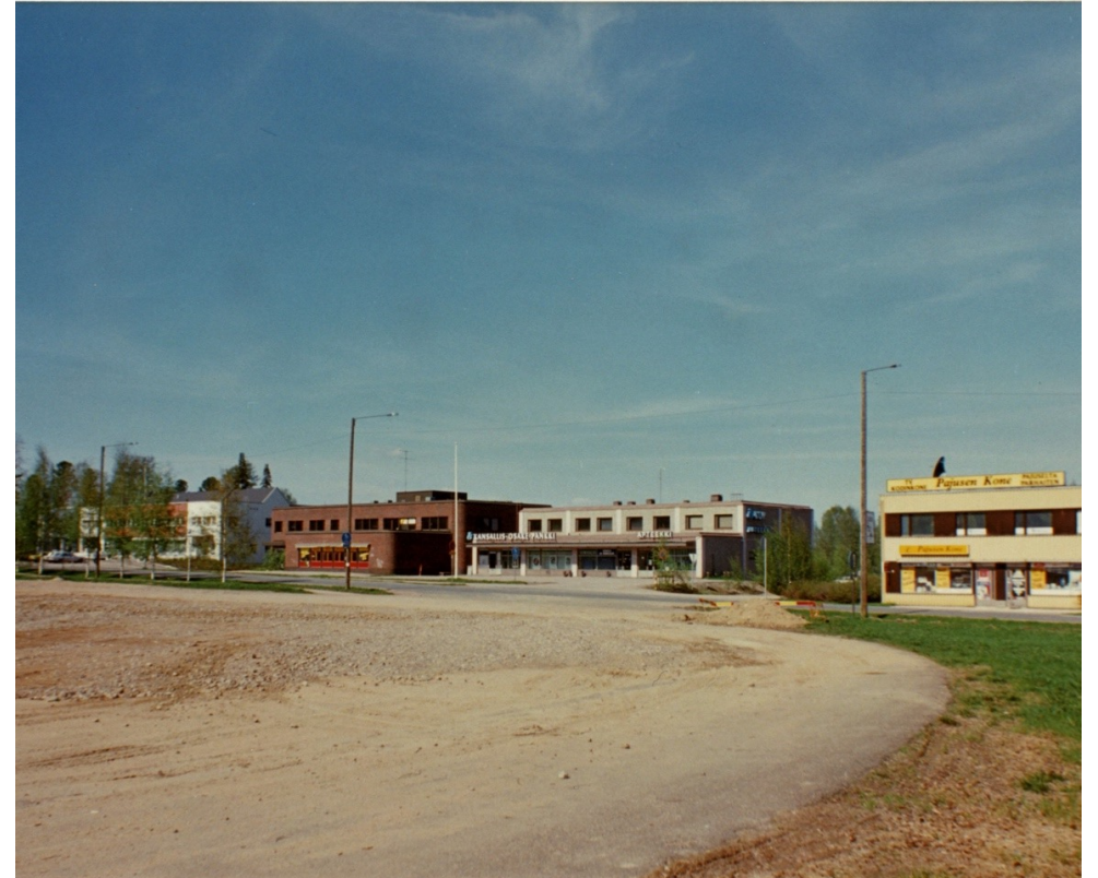
Kuva: Ylöjärven Muisti kotiseutuarkisto, Reijo Suojanen
