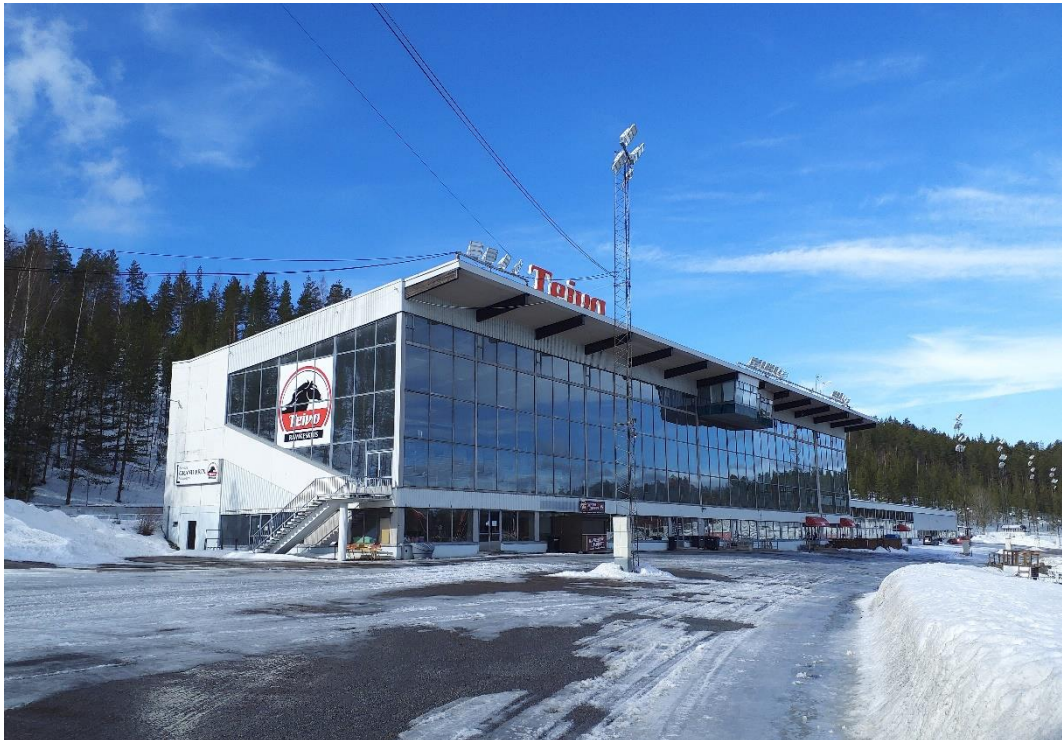
Kuva 28 Teivon ravirata-alueen katsomorakennus sijaitsee raviradan lounaispuolella.
