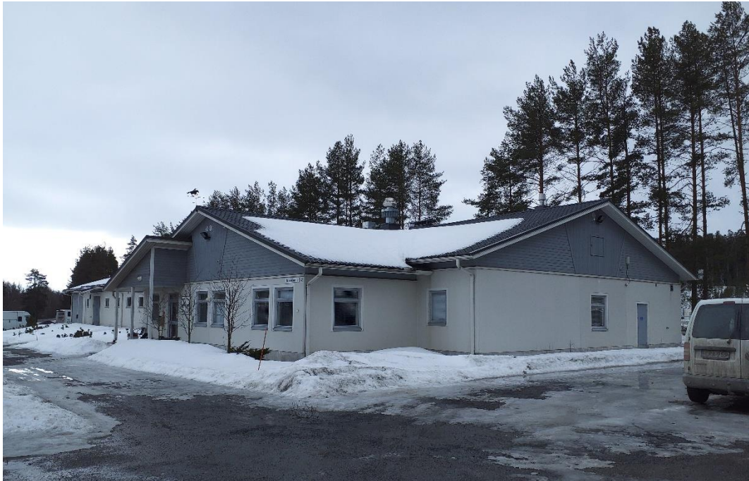
Kuva 40 Hevosklinikka on sijoittunut Mikkolantien varteen, raviradan itäpuolelle.
