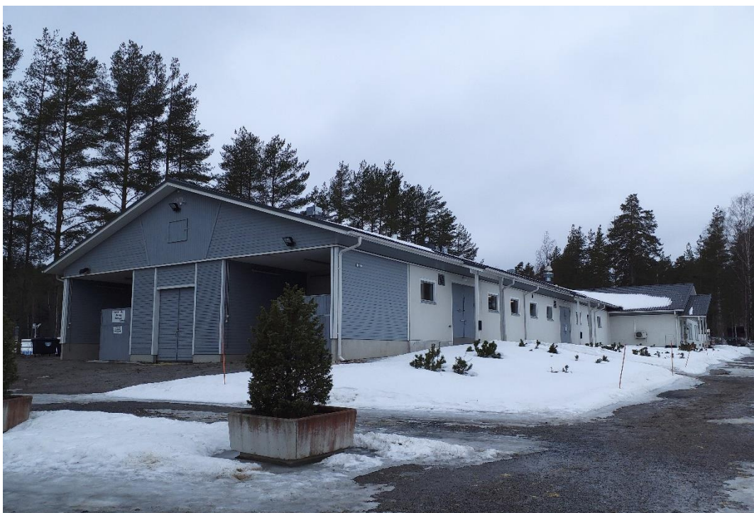
Kuva 41 Hevosklinikka on pitkänomainen, yksikerroksinen ja satulakattoinen rakennus.
