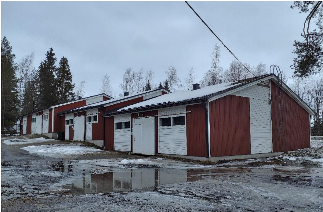
Kuva 39 Valjastusrakennuksen massa muotoilee laskevaa maastoa.
