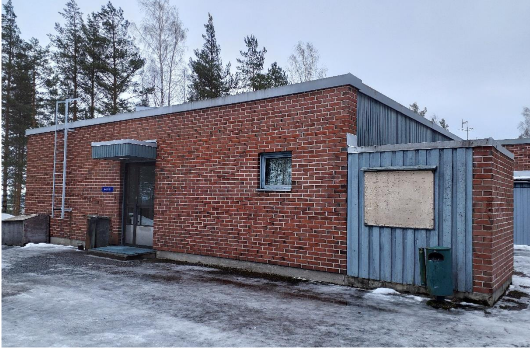
Kuva 43 Ulkoilumajan julkisivumateriaali on punatiiltä, ja yksikerroksisessa rakennuksessa on tasakatto.
