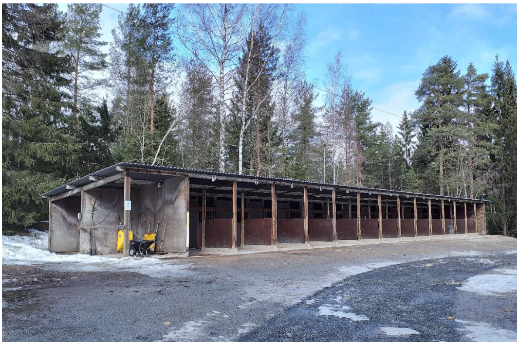
Kuva 33 Valjastuskatokset ovat nimensä mukaisesti avoimia katosrakennelmia, jotka on jaettu pienempiin osioihin.
