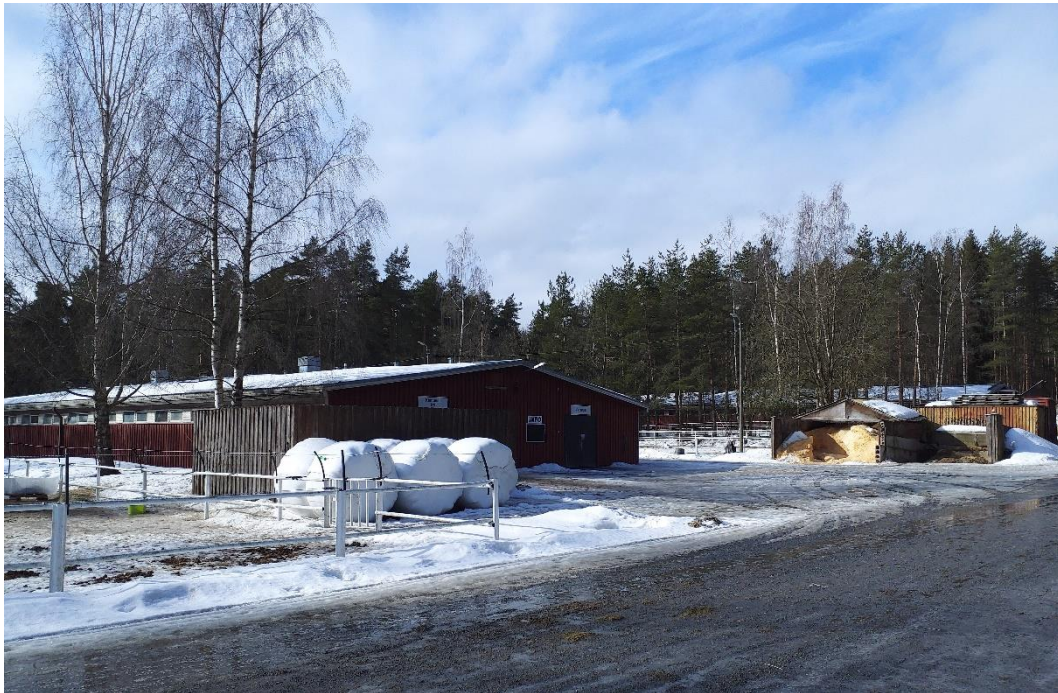
Kuva 31 Tallirakennusten ympärillä on runsaasti puustoa, ja niiden ympäri kulkee ohjastajille tarkoitettu tie.
