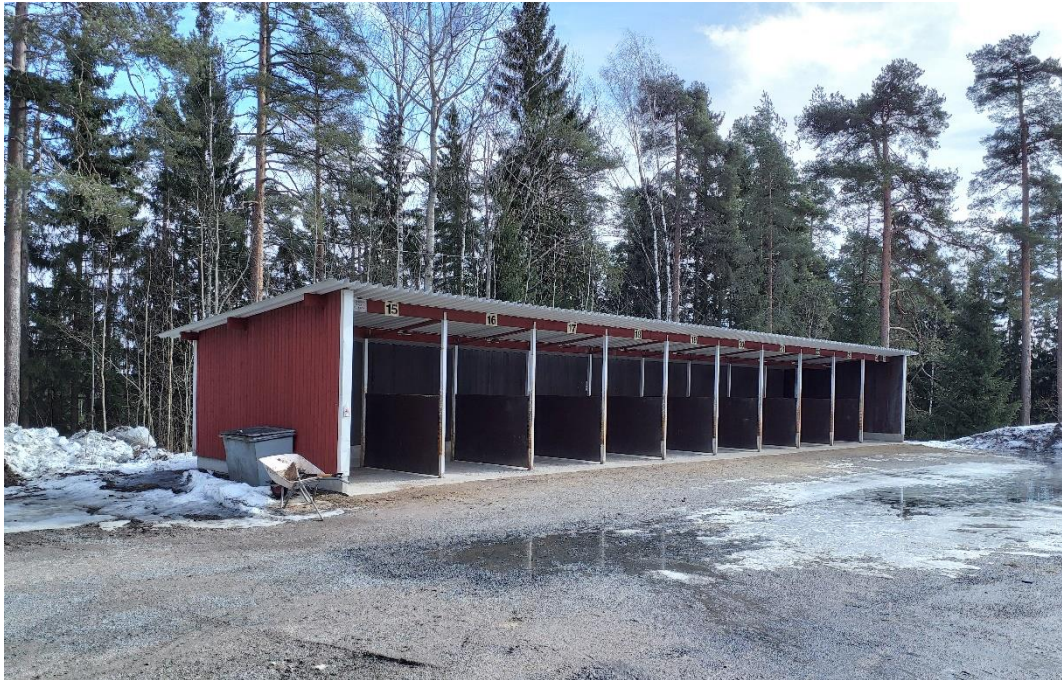
Kuva 32 Tallirakennusten itäpuolella sijaitsevien valjastuskatosten alueella on eri-ikäisiä rakennelmia.
