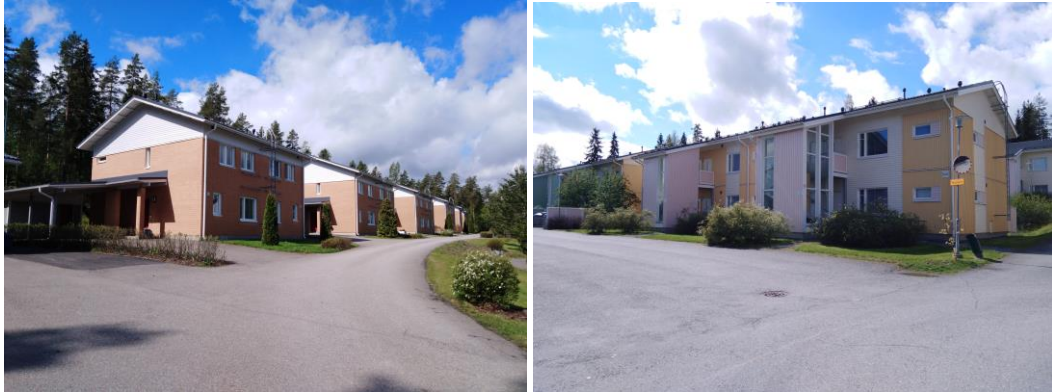
Kuva 16 Mikkolantien varrella olevissa asuinrakennuskokonaisuuksissa on myös 2000-luvulla rakennettuja paritaloja (vasemmalla) ja luhtitaloja (oikealla).
