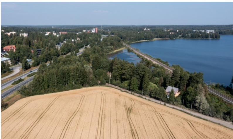
Kuva: Päärata. Näkymä Mäkkylänpellolta Soppeenmäkeen (vasemmalla) ja Keijärven rannan virkistysalueille Aronrantaan ja Pappilanniemeen (oikealla). Kevyen liikenteen reitin rakentaminen ratapenkkaan järven puolelle on keskeistä Mäkkylän pellon uuden asuinalueen toimivuuden kannalta (Rami Marjamäki 2022).
